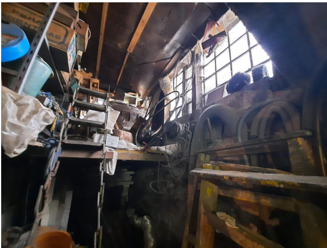
Vista interna magazzino
